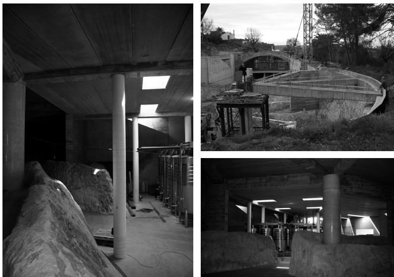
33-35. Foto cantiere cantine Can Rafols dels Caus
